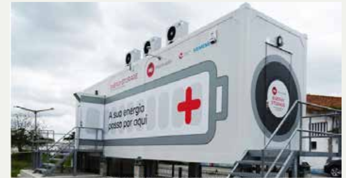
Figure 1 - EDP Distribuição Energy Storage System
